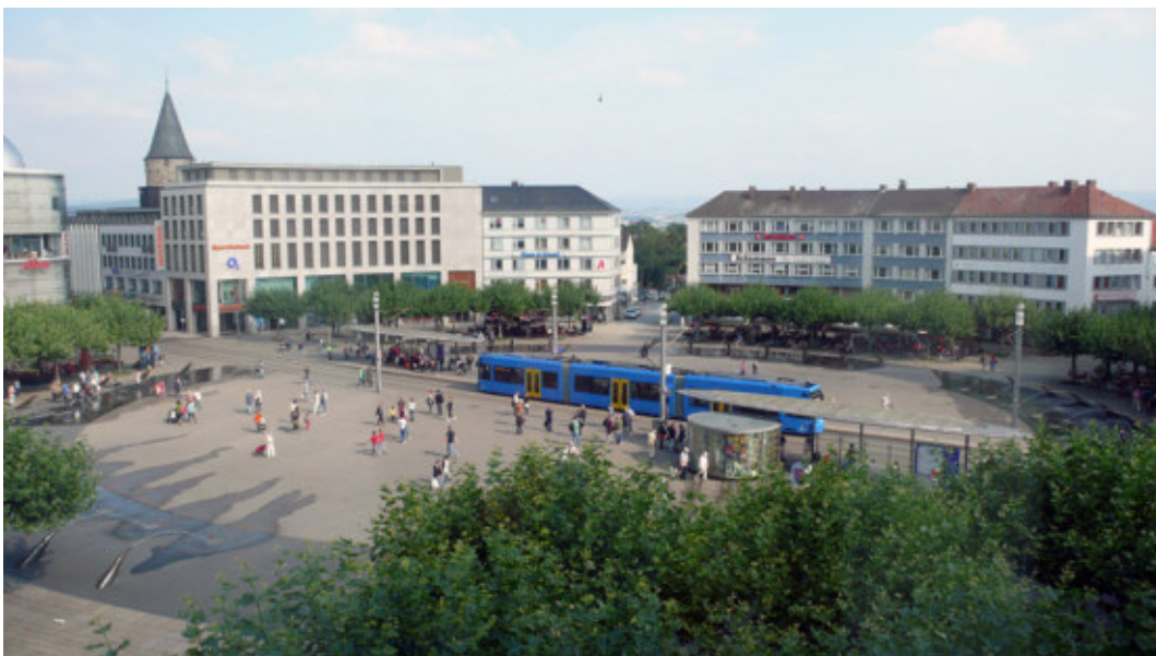
Der Königsplatz 2014, vergleichbarer Blick wie 1820. Die innere Platzfläche aus Asphalt ist eintönig und ungliedert, so dass die (zudem tief eingeschnittene) Straßenbahntrasse umso stärker als Trennlinie auffällt. Beides bedeutet, dass in der gesamten Innenfläche die Struktur des Platzes – als kreisförmiges Gelenk mit sechs Straßeneinmündungen – negiert wird; hierin besteht das eigentliche Problem, das durch zusätzliche, exzentrisch positionierte Objekte (wie den 16 m hohen Obelisk vor dem City-Point) noch weiter verstärkt würde.
