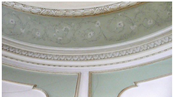
Blick auf Deckengesims und Fries im runden Saal
