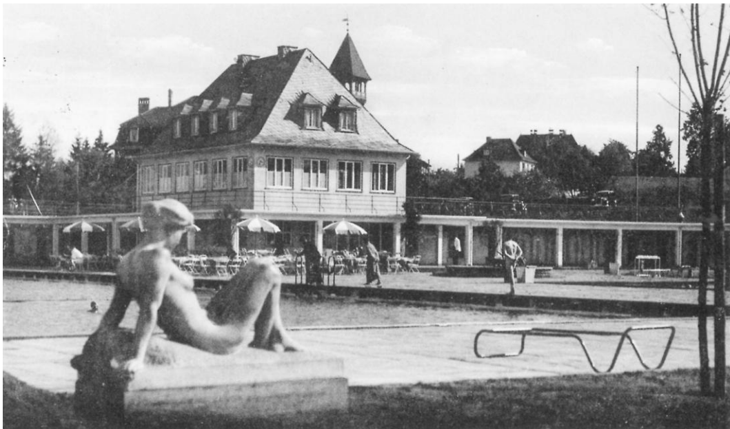
Abb. 3: Blick von der Pergola über das 50m-Becken auf Hauptgebäude und Seitenflügel. Die Stützenreihen bilden einen durchgehenden Laubengang vor dem Sockel des Hauptgebäudes und vor den Umkleideräumen; die moderne Leichtigkeit der Architektur ist zur Zeit noch durch nachträgliche Vermauerungen beeinträchtigt. Im Vordergrund erkennt man die Figur „Ruhendes Mädchen“ (Fritz Klimsch) aus dem Landesmuseum, die hier von 1936 bis 1942 aufgestellt war. Der "Ruhende Jüngling", der im gleichen Zeitraum am anderen Ende der Pergola postiert war, ging 1943 im Rathaus unter. (Ansichtskarte; Sammlung Forssman)
